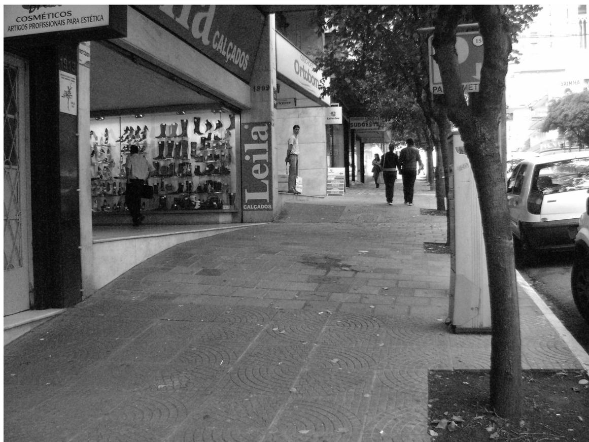
Figura 6: Inclinação longitudinal dos passeios
